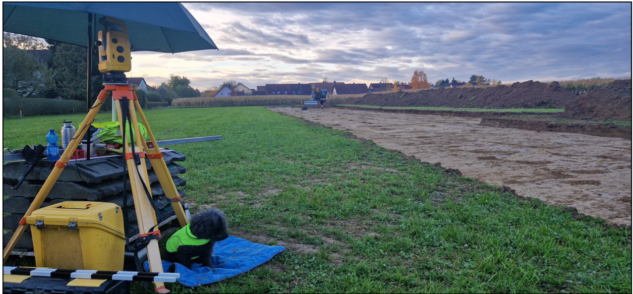
Abb. 9 Oberbodenabtrag im Bereich der Erschließungsstraße.
