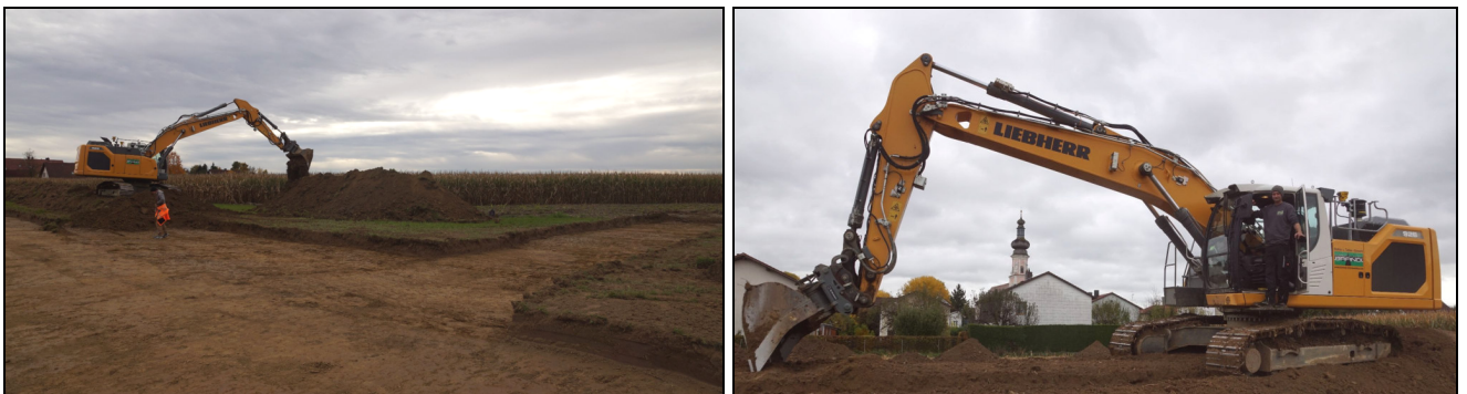
Abb. 2 Links: Oberbodenabtrag (anfallendes Material seitlich gelagert). Rechts: Herr Staudinger mit seinem Arbeitsgerät.
