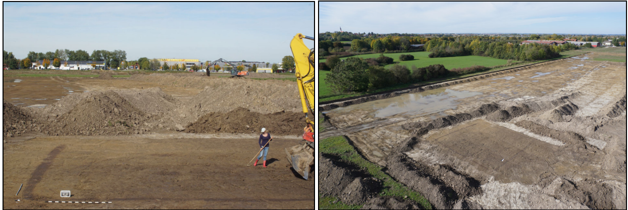
Abb. 131 Links: Fertigstellung des Planums. Rechts: Luftbild von Herrn Kluthe (© S. Kluthe, 15.10.2019).
