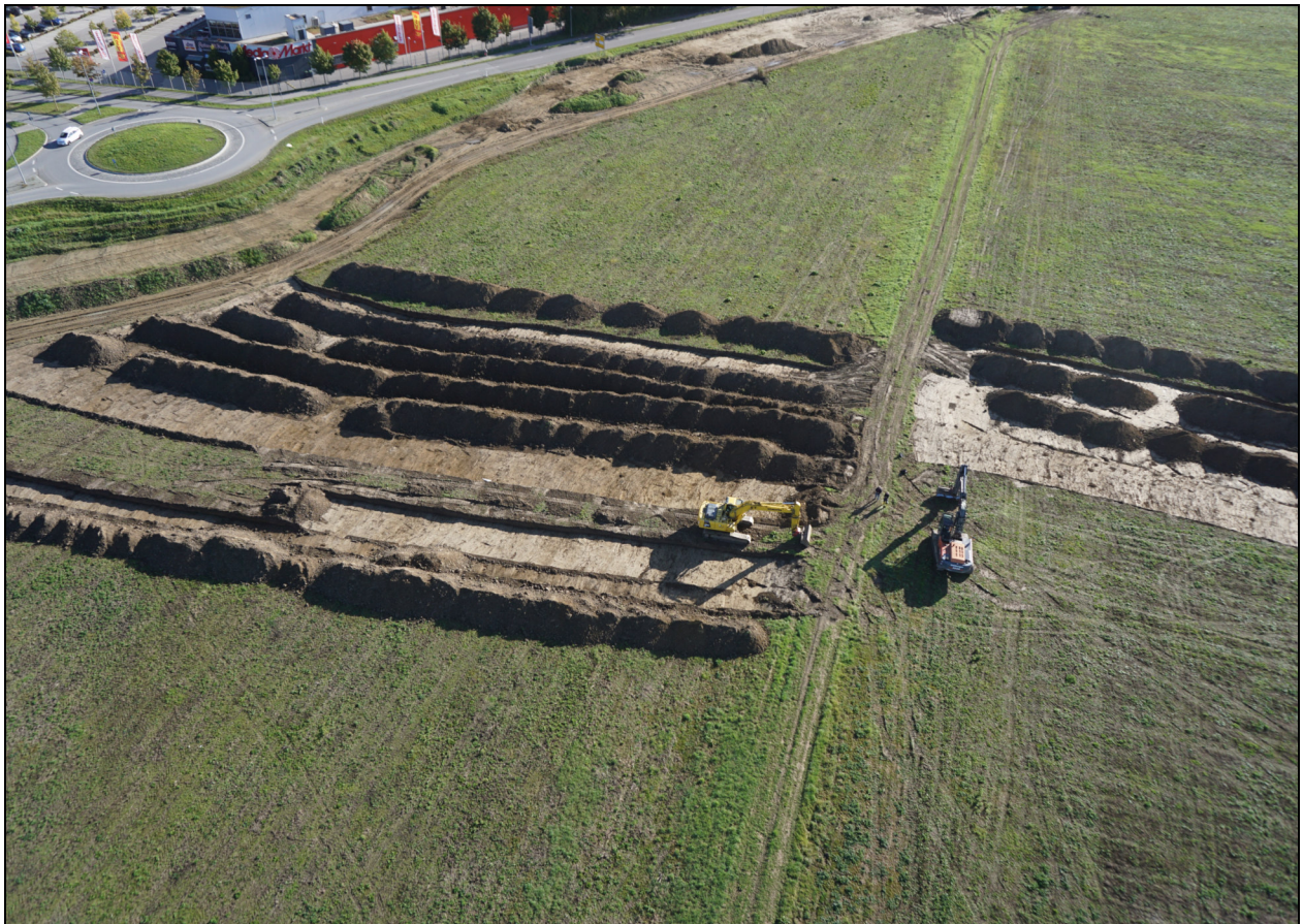
Abb. 10 Rollierender Oberbodenabtrag (© S. Kluthe 29.09.2019).
