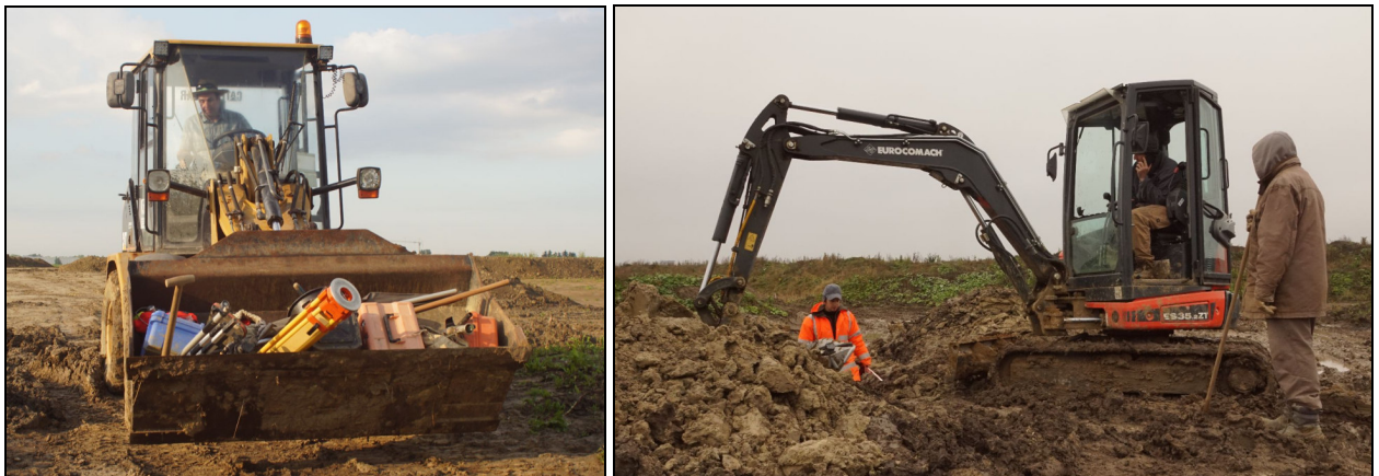
Abb. 12 Links: Transport von Werkzeug und Gerät mit dem Radlader. Rechts: Minibagger.
