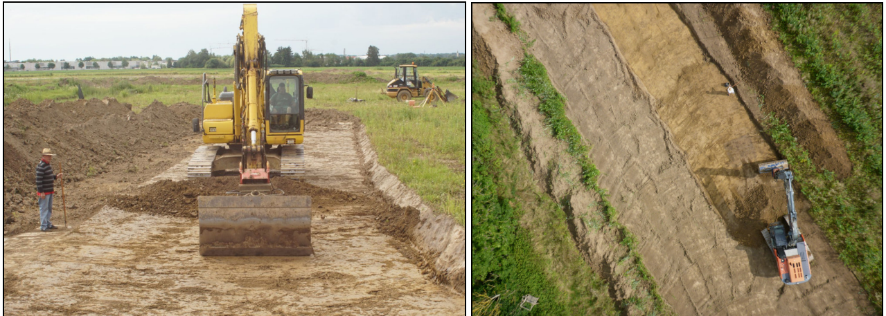
Abb. 9 Feinplanie im Bereich von zuvor oberflächlich abgezogenen Streifen.
