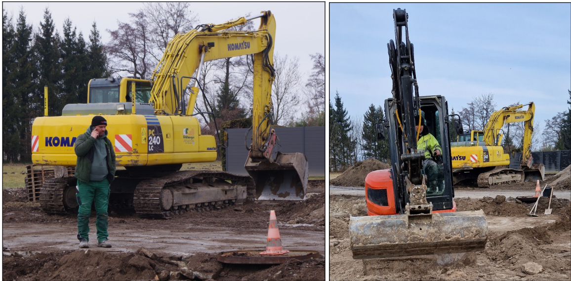
Abb. 9 Links: Herr Güler managt die Baustelle. Rechts: Der Minibagger.
