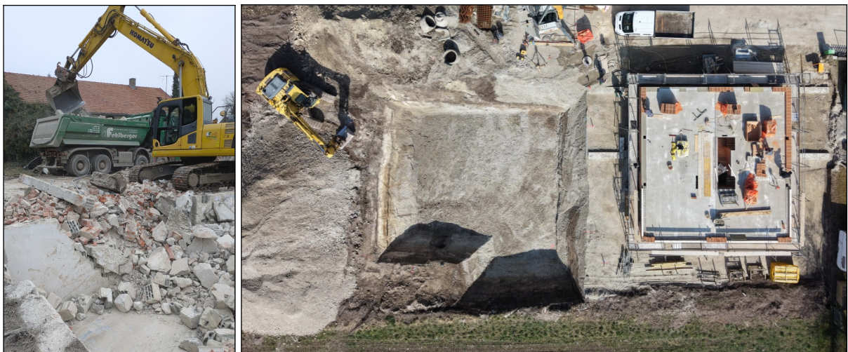
Abb. 2 Links: Abtransport des Bauschutts. Rechts: Luftbild vom 23.02.2026.
