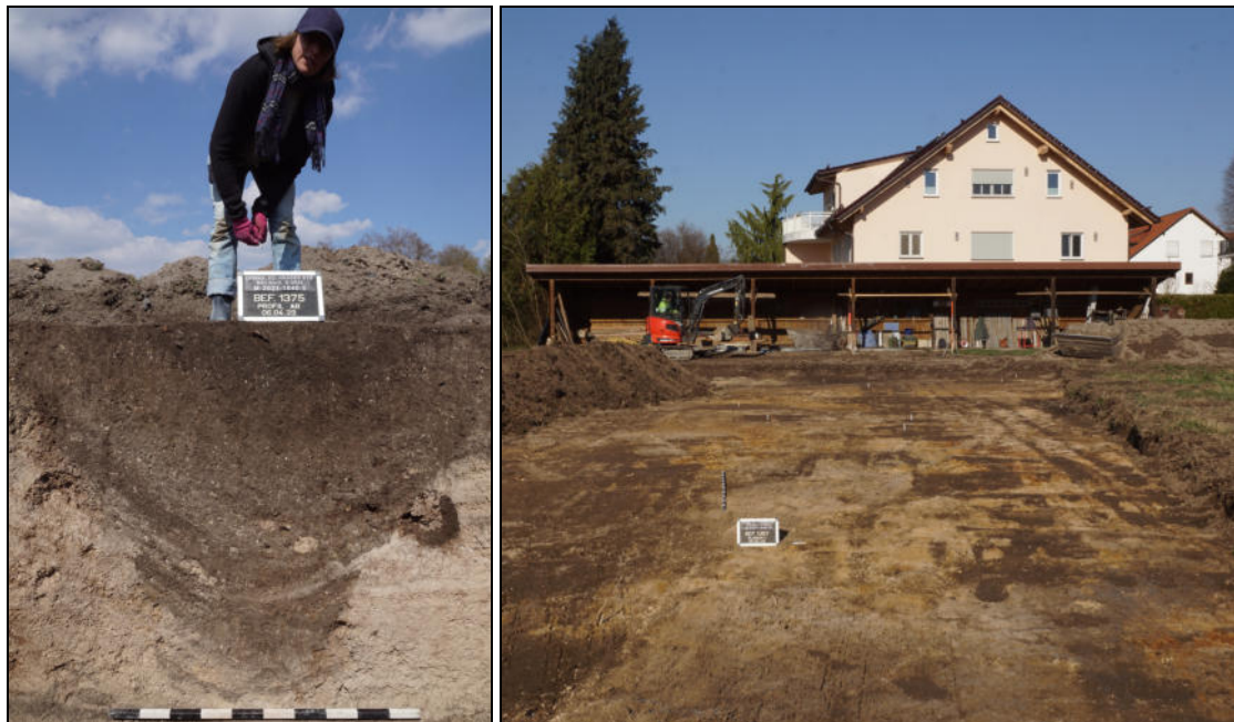
Abb. 3 Links: tiefer römischer Straßengraben am Südrand von BA1 Nord..
