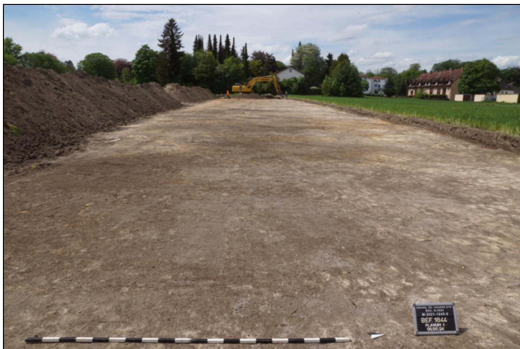
Abb. 4 Befundloser Abtragsstreifen mit geringer Humusauflage im Mittelteil von BA2.
