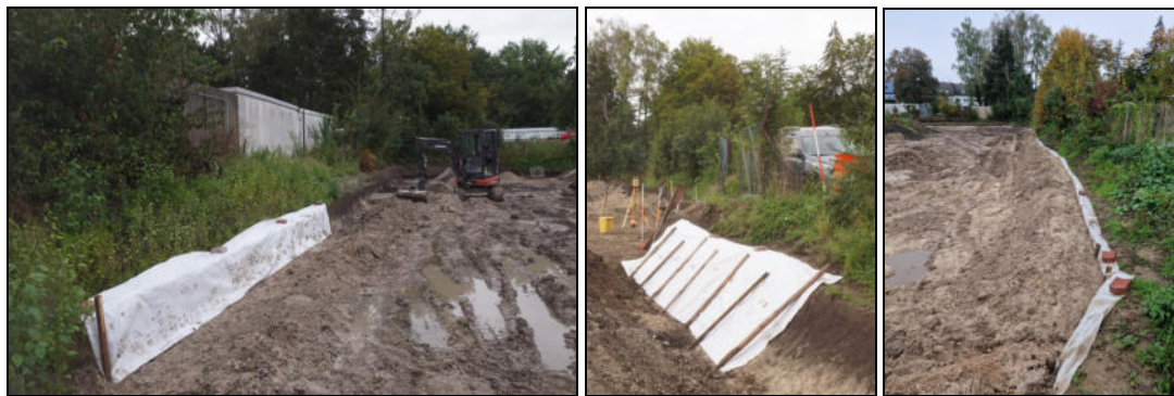
Abb. 4 Sicherung der Profile am Grabungsrand mit einem Geotextilvlies.
