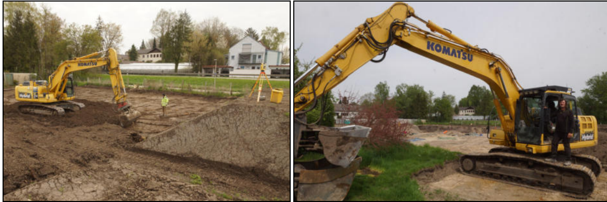
Abb. 1 Links: Abtrag der Humusdecke bis auf die Oberkante des Hangkolluviums im Bereich der Altheimer Siedlung. Rechts: Herr Karoly Ruda von Fa. Fehlberger gegen Ende der Erdarbeiten.
