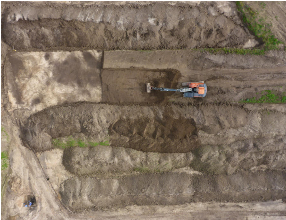
Abb. 5 Rollierender Oberbodenabtrag mit Humusmieten auf bearbeiteten Streifen (Luftbild mit dem Hebedrachen).
