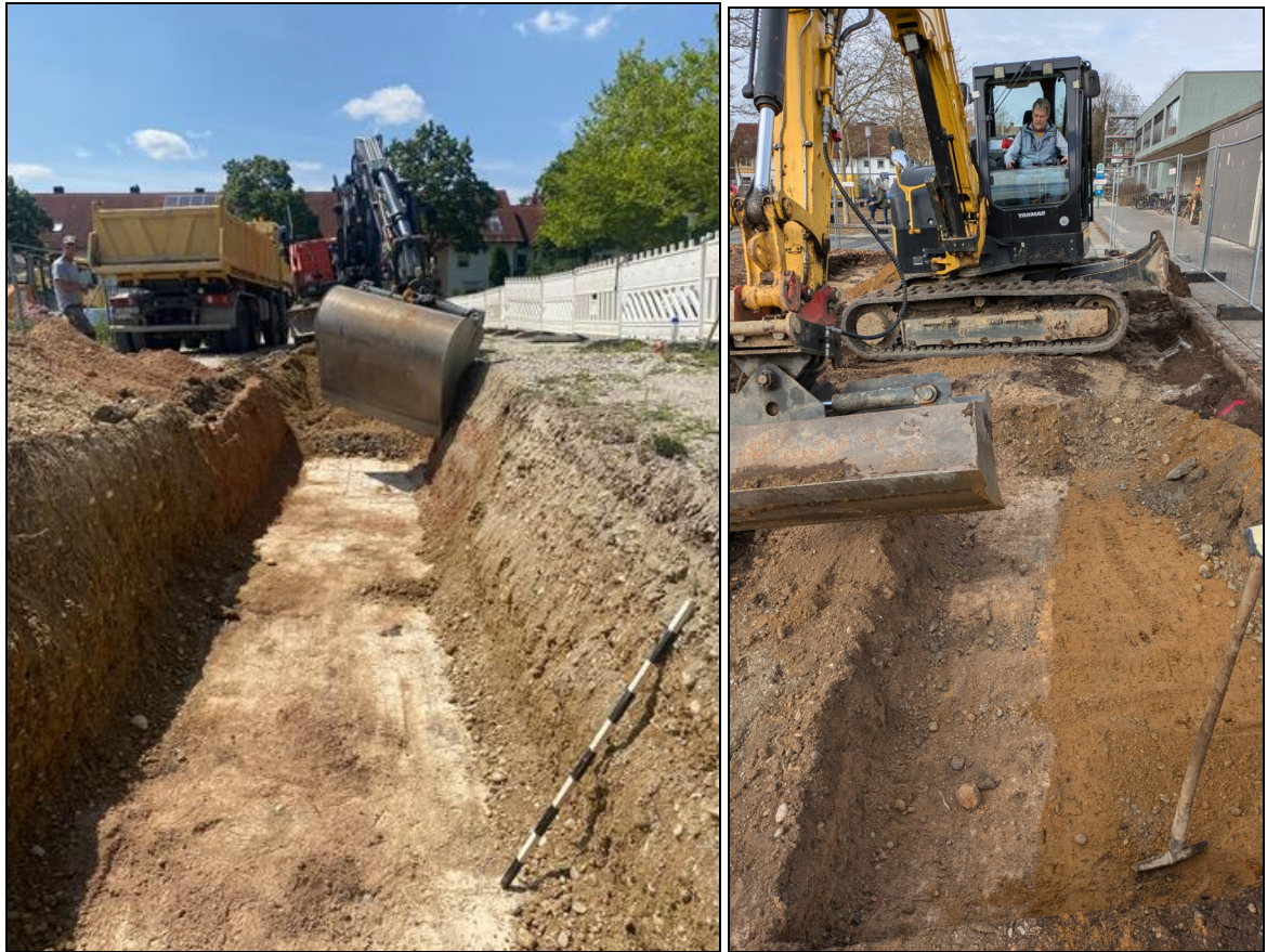
Abb. 5 Links: Baggerarbeiten an der neuen Kanaltrasse durch Fa. Hörhammer. Rechts: Parkplatzerweiterung durch Fa. Brandl.
