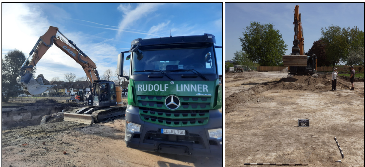
Abb. 4 Links: Abbrucharbeiten von Fa. Linner im Februar 2024. Rechts: flächiger Oberbodenabtrag ab Ende April 2024.
