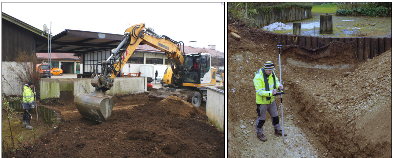
Abb. 2 Links: Baggerarbeiten. Rechts: Aufmaß der Oberkante des ungestörten Hochterrassenschotters.
