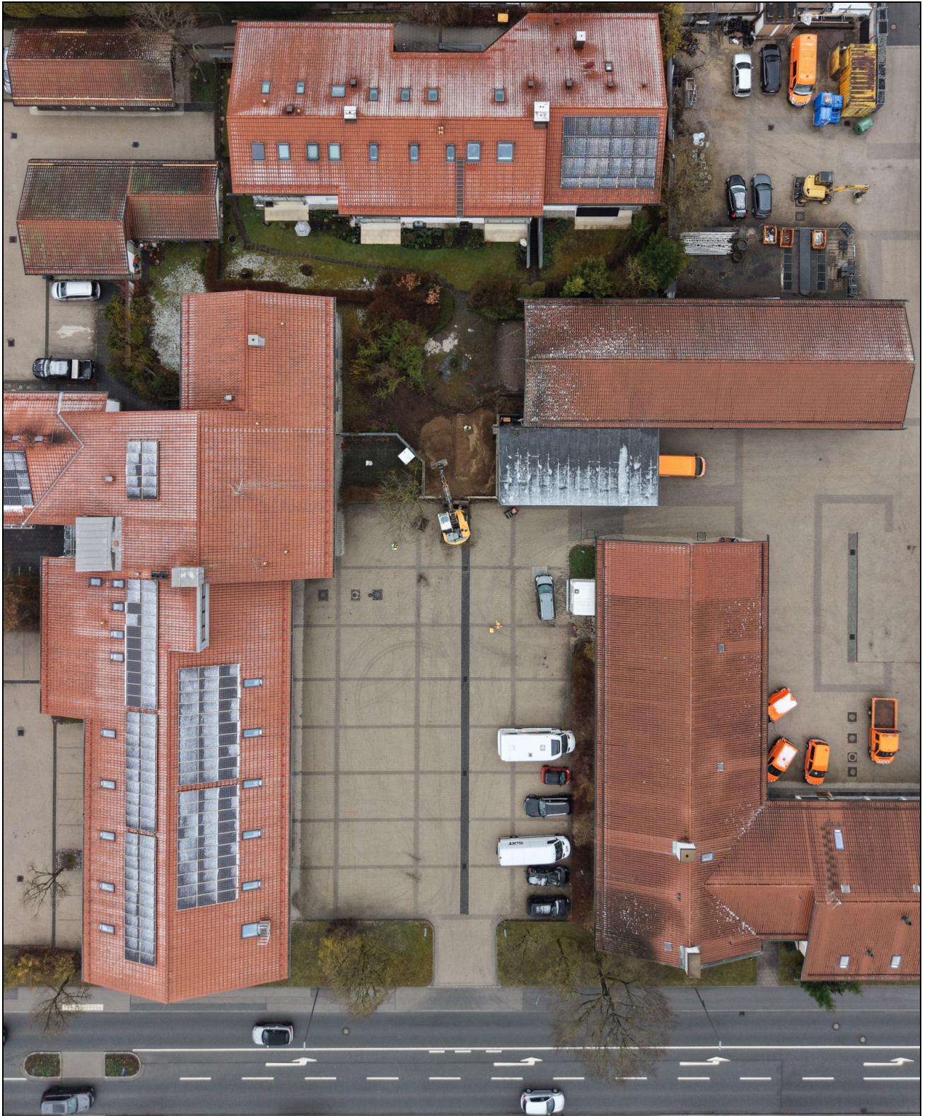
Abb. 3 Der Gebäudekomplex der Feuerwehr (links) und des Bauhofes (rechts) im Luftbild während der Baggerarbeiten.
