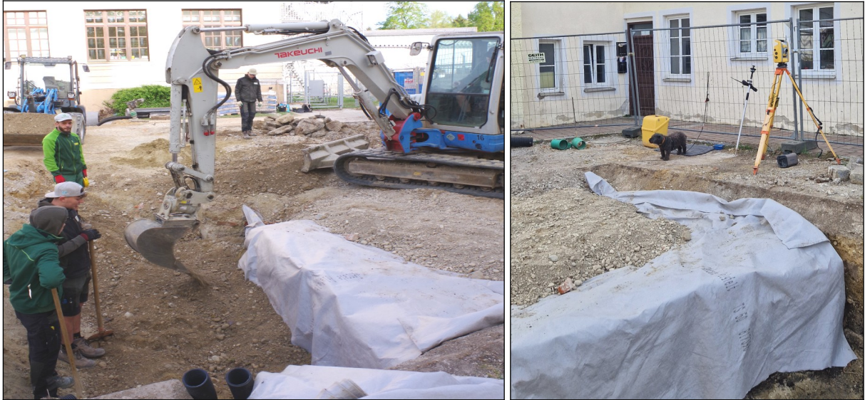
Abb. 31 Überdeckung der Fundamente mit Geotextilvlies und anschließende Aufkiesung.
