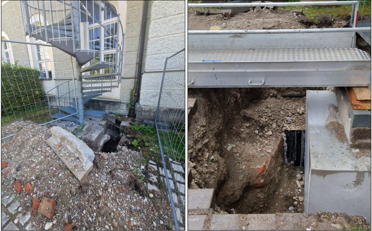
Abb. 27 Links: freigelegtes Fundament der Wendeltreppe am 18.08.2025 gegen Nordosten. Rechts: neues Fundament am 24.09.2025. Links ist Kanalwange Bef. 15 zu erkennen.
