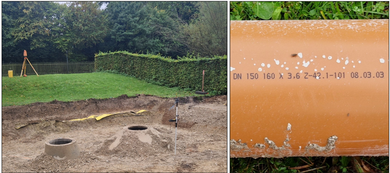
Abb. 24 Links: Sickerschächte Bef. 6 und 7. Hinten Graben einer Starkstromleitung Bef. 8. Rechts: KG-Rohr der Regenentwässerung aus Störung Bef. 10 mit Datumsaufdruck 08.03.[20]03.
