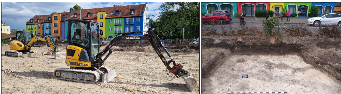
Abb. 2 Links: Minibagger mit 4 und 2,5 Tonnen. Rechts: Teilfläche mit Kleinbefunden an der Betonmauer entlang der Flurstücksgrenze.
