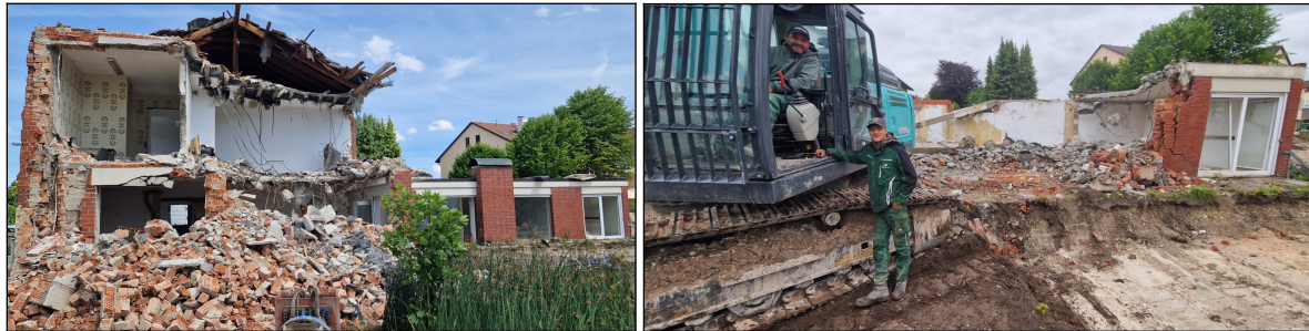
Abb. 1 Abbruch der Vorgängerbebauung durch Fa. Fehlberger.
