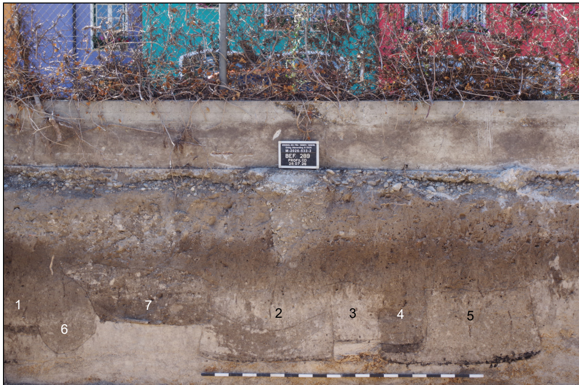
Abb. 1 Teilprofil an der Südgrenze mit sich überschneidenden Öffnen (1-5), einer Pfostengrube (6) und einer Wasserleitung (7).
