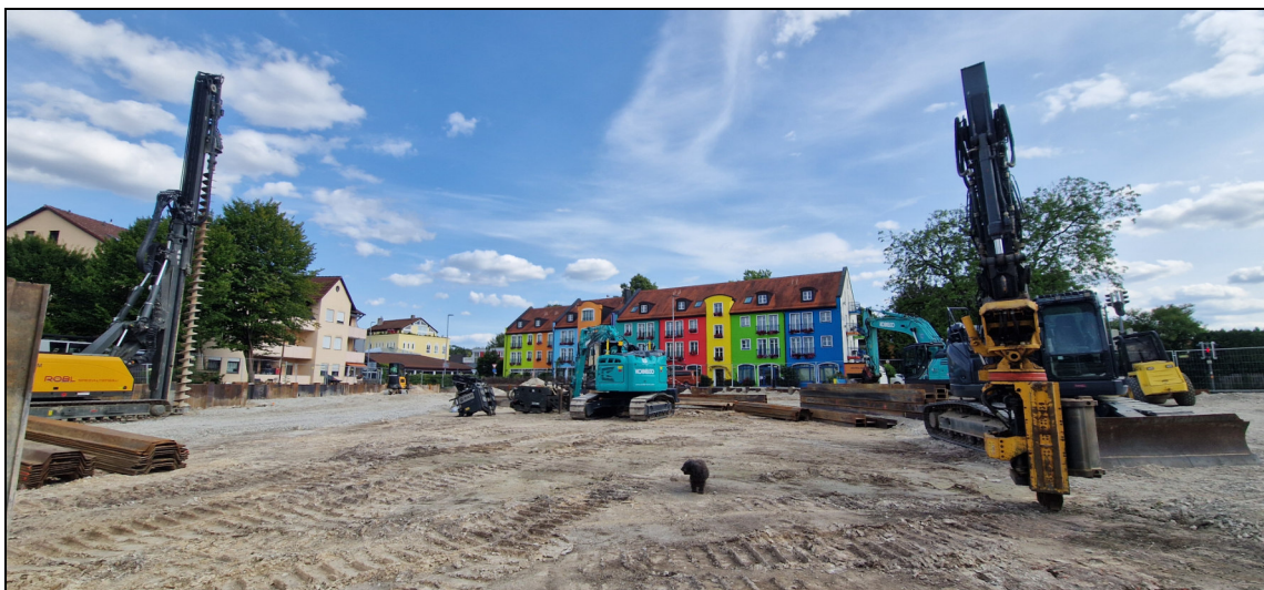
Abb. 7 Grabungsende an der Von-Puech-Straße.
