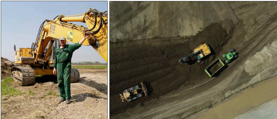
Abb. 7 Links: Herr Taferner aus Feldgeding. Rechts: Humusarbeiten in GE 8.
